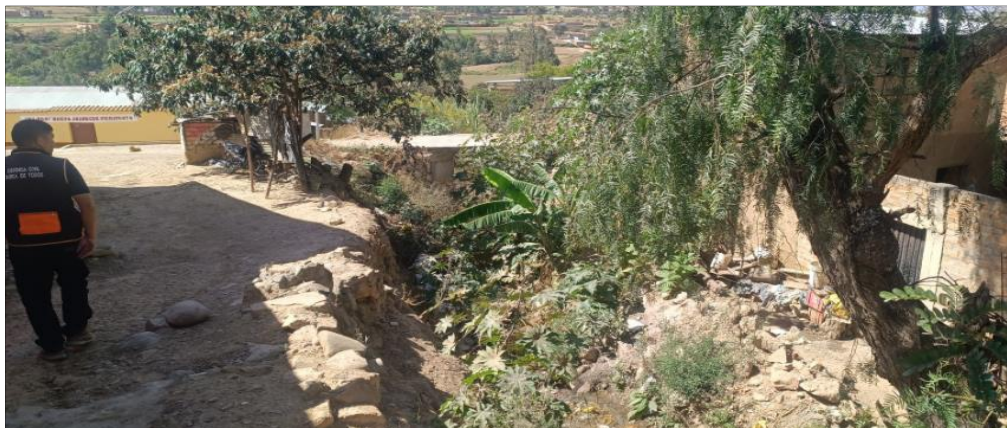
Panorámica de un tramo de la quebrada donde se evidencia la erosión de las márgenes de tierra, lo que amenaza el camino adyacente y el terreno de las viviendas cercanas.
